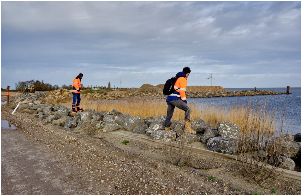
Foto: Inspectie Markermeerdijken bij wateroverlast in december 2023
