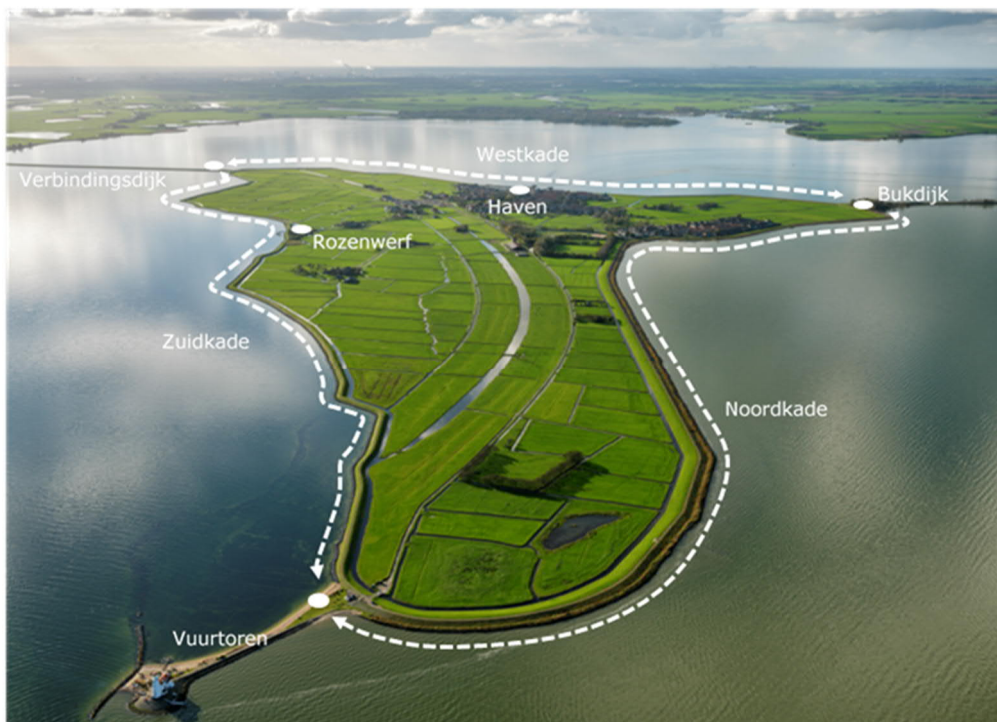
Figuur 1 De dijken rond Marken. De dijkversterking betreft de Zuidkade, de Westkade en de Haven
