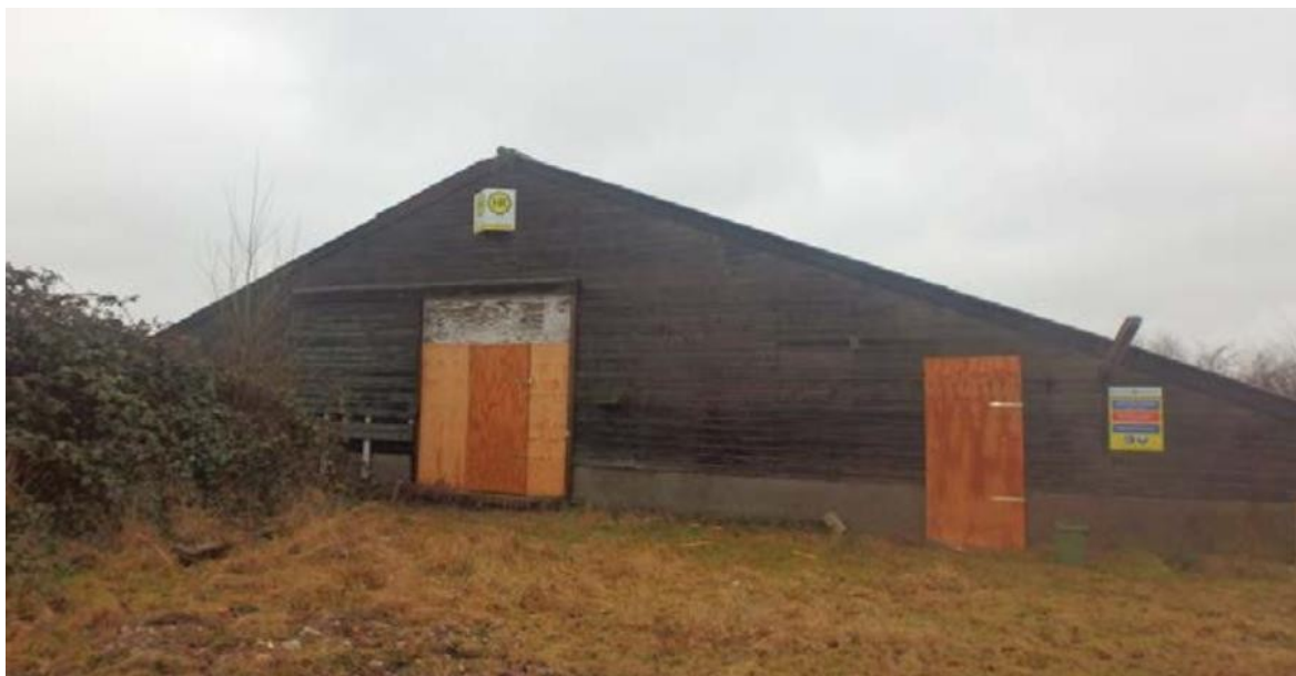
Afbeelding huidige bebouwing projectlocatie
