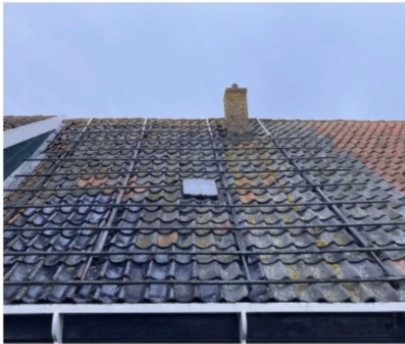
dak met dakvenster. Stormlatten blijven gehandhaafd en gerestaureerd daar waar nodig.
