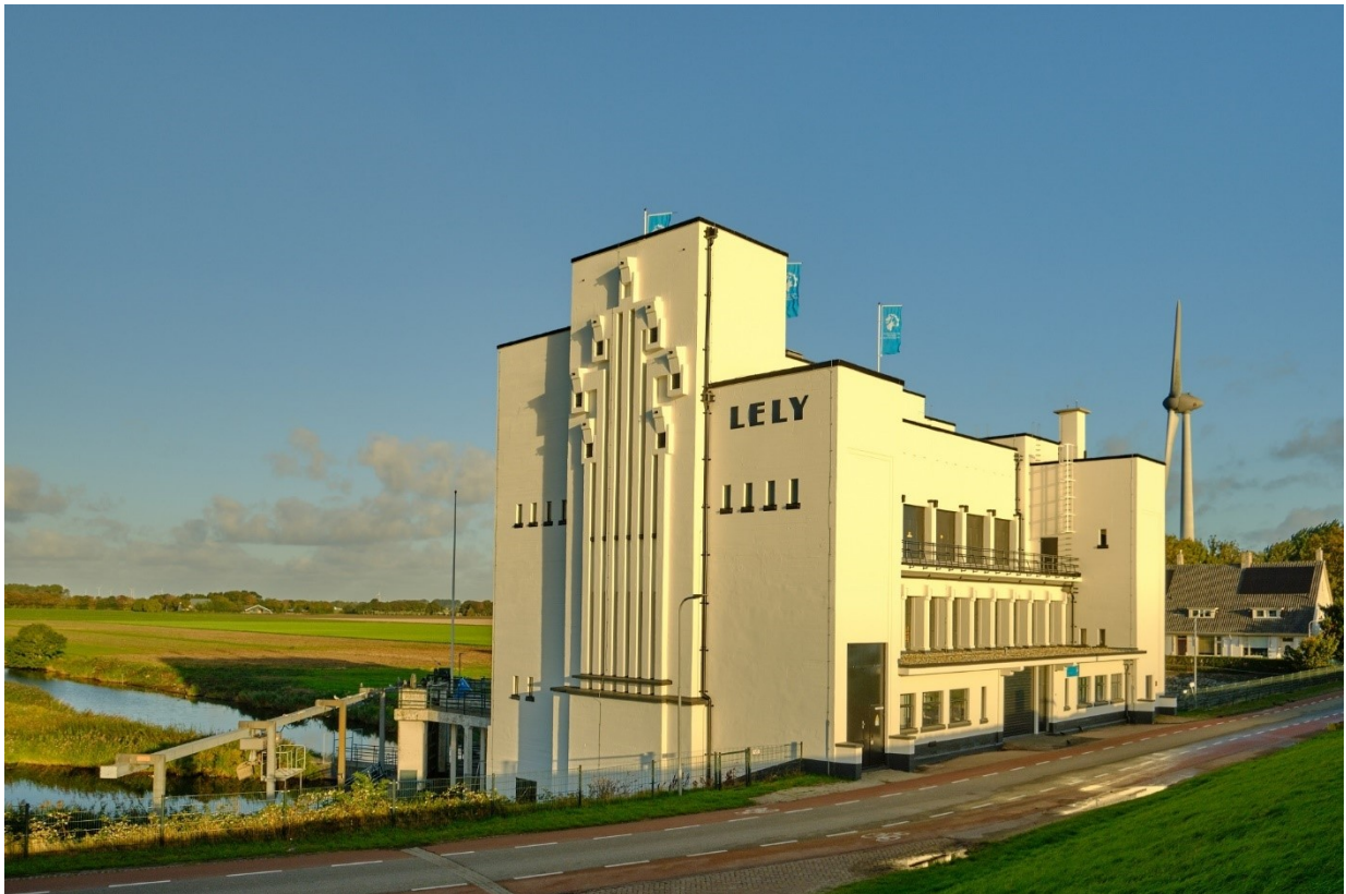
Foto: Gemaal Lely na grondige renovatie
