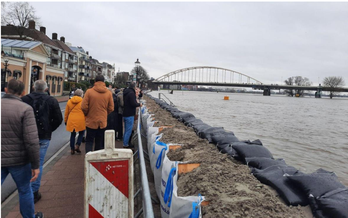
Figuur 4.1 Zandzakken aan de IJsselkade in Deventer. Foto: Ronald Roosjen.
