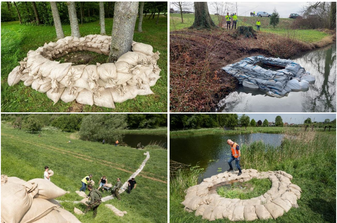
Figuur 3.6 Opgekiste wellen (bron: Hoogheemraadschap De Stichtse Rijnlanden).
