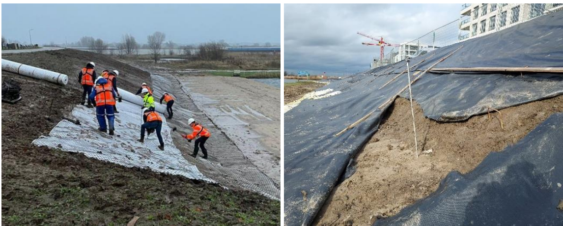
Figuur 3.1 Dijken in uitvoering. Links het aanbrengen van krammatten op een dijk in uitvoering (bron: W. Halter). Rechts schade aan afdekkende doeken bij Zutphen (bron: Waterschap Rijn en IJssel).
