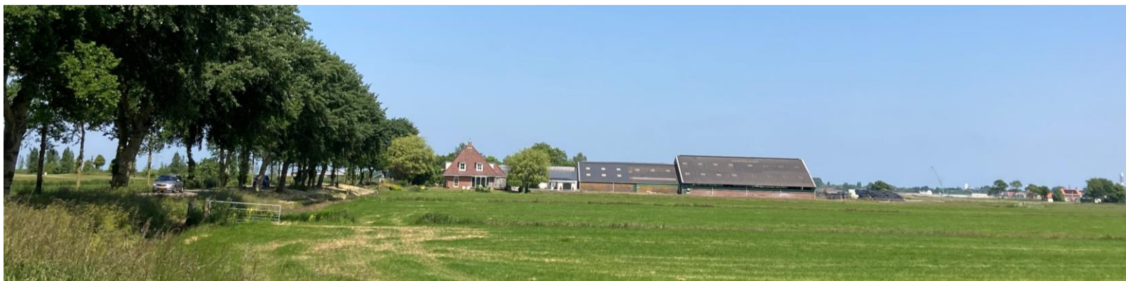
Figuur 4.9 Groot erf met geringe erfbeplanting langs noordelijk deel van de Zeedijk, die hier beplant is
