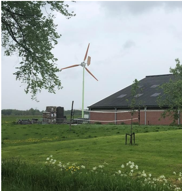
Figuur 2.3: Kleine windturbine in het landelijk met een evenwichtige verhouding tussen masthoogte en rotordiameter gebied (EAZ turbine) Vermogen 0,01 MW / Opbrengst 25 MWh/jaar
