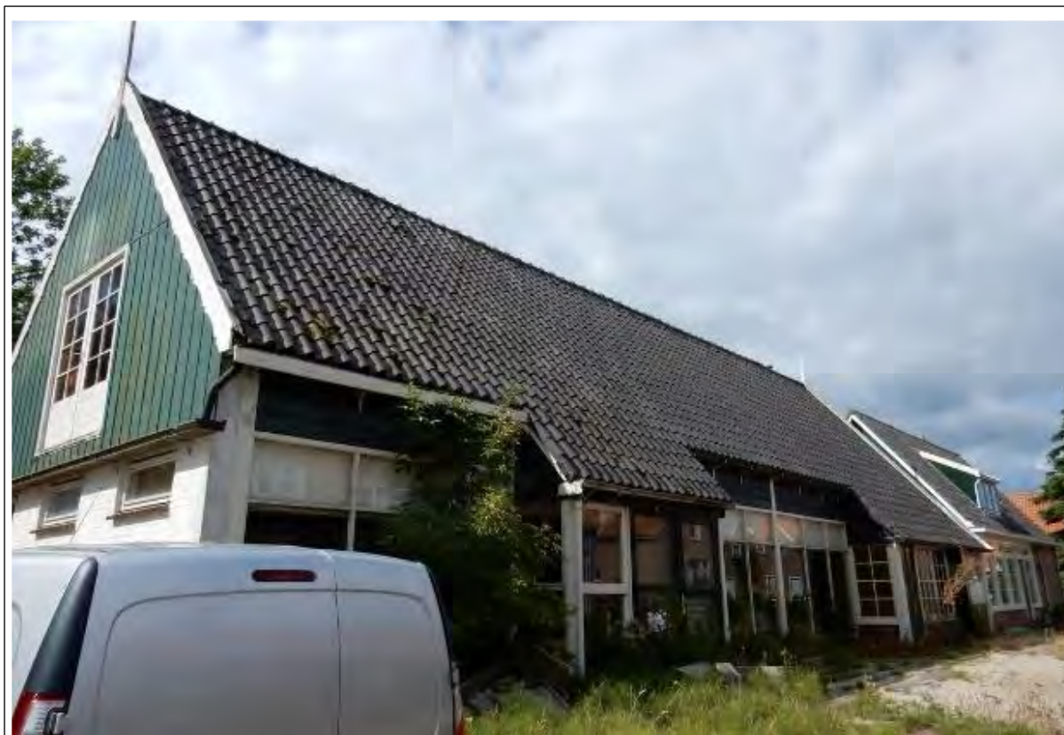
Figuur 4 – De voor en zijgevel van de bestaande bebouwing op het perceel Westerstraat 25
