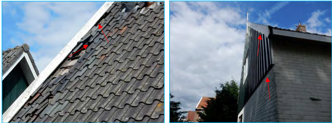
Foto's: Openingen die toegang kunnen bieden naar mogelijke vaste verblijfplaatsen van vleermuizen of kunnen dienen als verblijfplaats.
