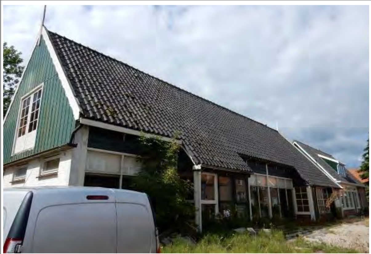
Figuur 4 – De voor en zijgevel van de bestaande bebouwing op het perceel Westerstraat 25
