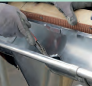
Dak- en zinkwerk
