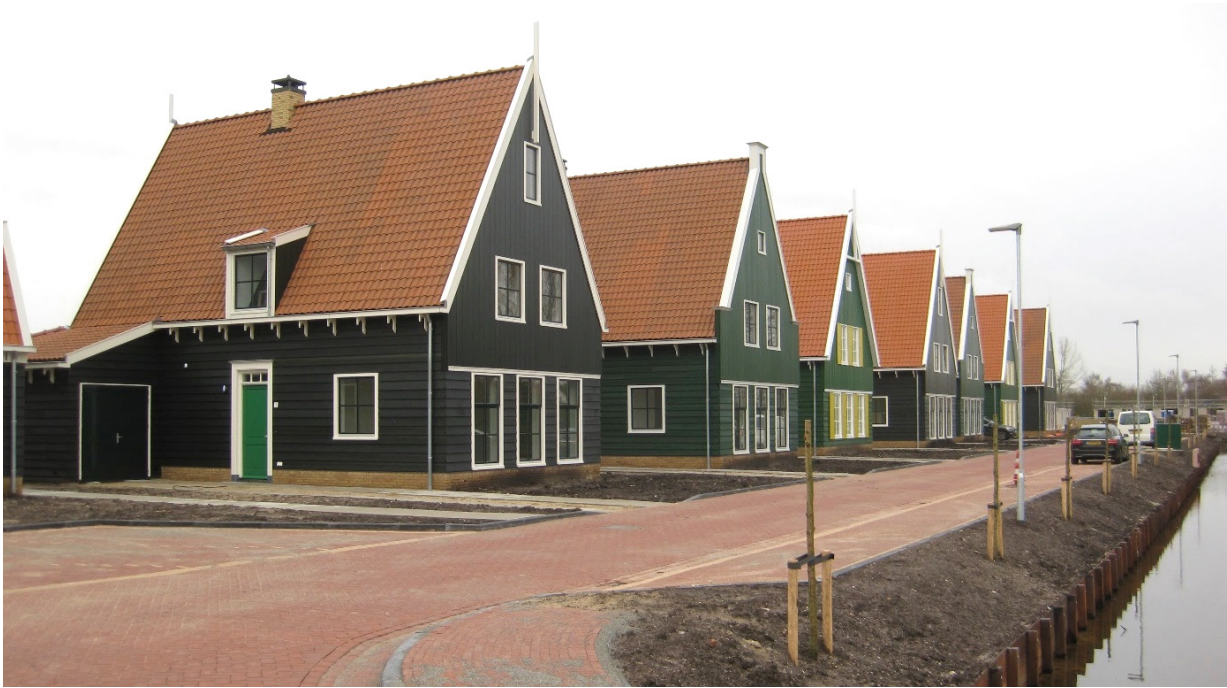
Nieuwbouw Watergang vormgegeven in stijl van de karakteristieke houtbouw in Waterland.
