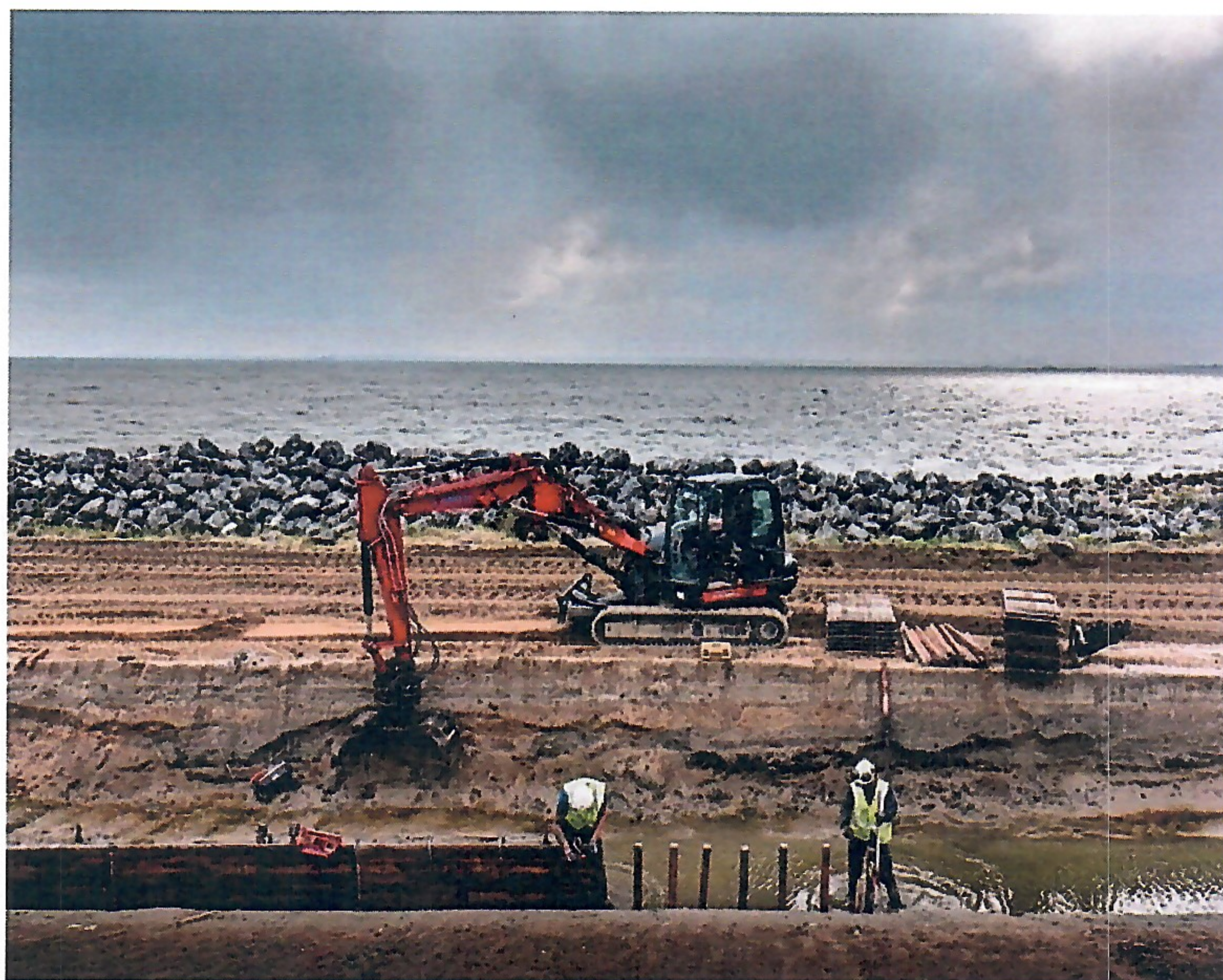
Werken aan de Uitdammerdijk.
